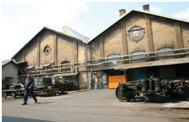
Slika 2 – Radionica za strojnu obradu i kotlovnica (izvor: http://gredelj-stanje-izmedju.tumblr.com )
