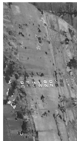
Korozija čelične armature betonskog rasyjetnog stupa
